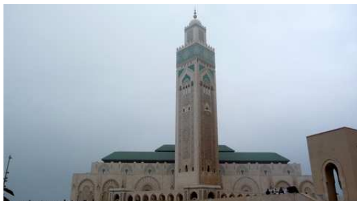
La mosquée Hassan II et son minaraie dans le brouillard
