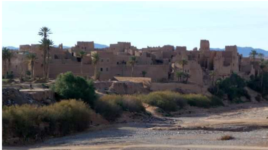
L'ancien Ksar en ruine de Tinejdad
