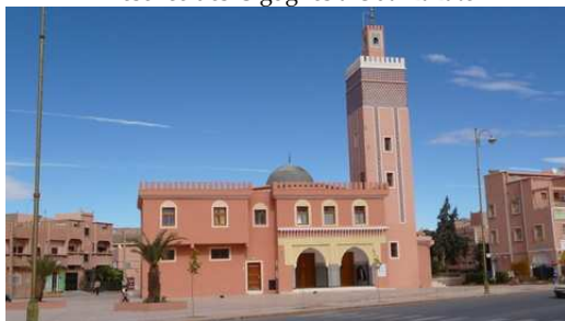
La Mosquée de Ouarzazate
